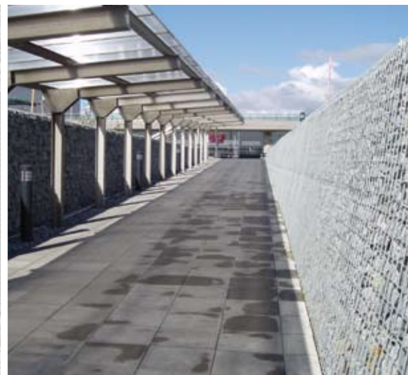
Vector Wall® Gabion opført i forbindelse med udvidelse af Arlanda Lufthavn, Stockholm.
