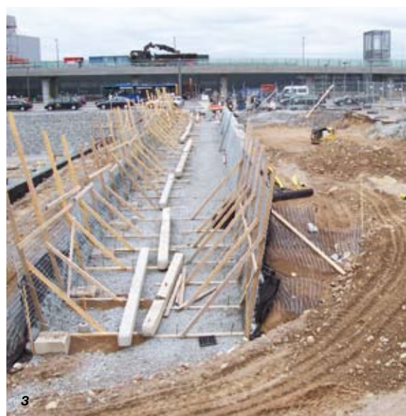
1. Håndlægning af stenindlæg i gabionvæg. 2. Afstandsstivere og forankringsgitter fastgjort til frontnettet. Geotekstil placeres mellem frontnet og geonet. 3. Vector Wall® frontnet opstillet og klar til det videre forløb.
