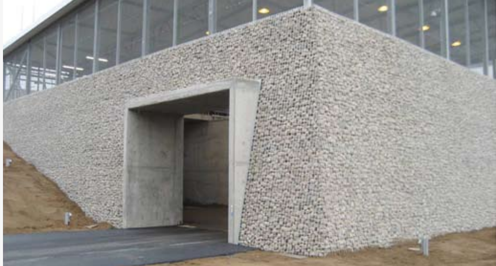
Vector Wall® gabionvæg fuldt integreret i øvrig bygningsværk. Jönköping Torsvik, Sverige.
