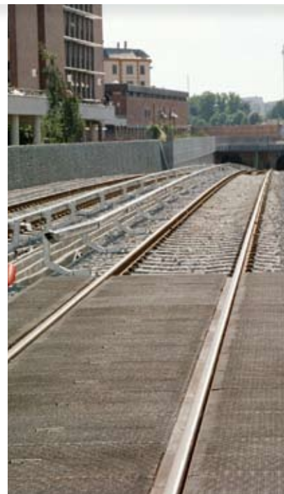
Vector Wall® opført langs den Københavnske Mini Metro ved Solbjerg
