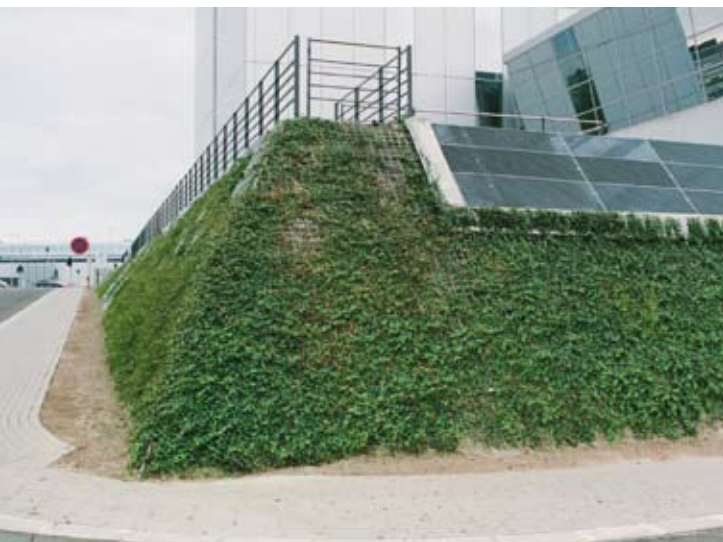
Vector Wall® Grøn opført ved Hotel Hilton, København.
