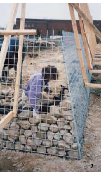
1. Håndlægning af stenindlæg i gabionvæg. 2. Afstandsstivere og forankringsgitter fastgjort til frontnettet. Geotekstil placeres mellem frontnet og geonet. 3. Vector Wall® frontnet opstillet og klar til det videre forløb.
