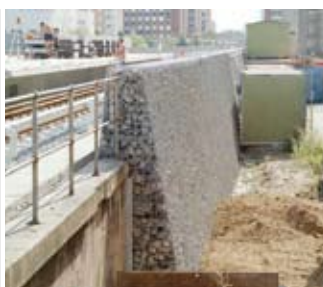
1. Håndlægning af stenindlæg i gabionvæg. 2. Afstandsstivere og forankringsgitter fastgjort til frontnettet. Geotekstil placeres mellem frontnet og geonet. 3. Vector Wall® frontnet opstillet og klar til det videre forløb.
